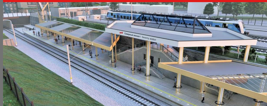
РЕКОНСТРУКЦИЯ платформ на станции Калининград-Северный
